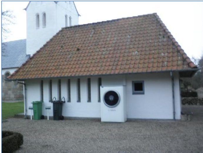
En luft til vand varmepumpe ved et graverhus
